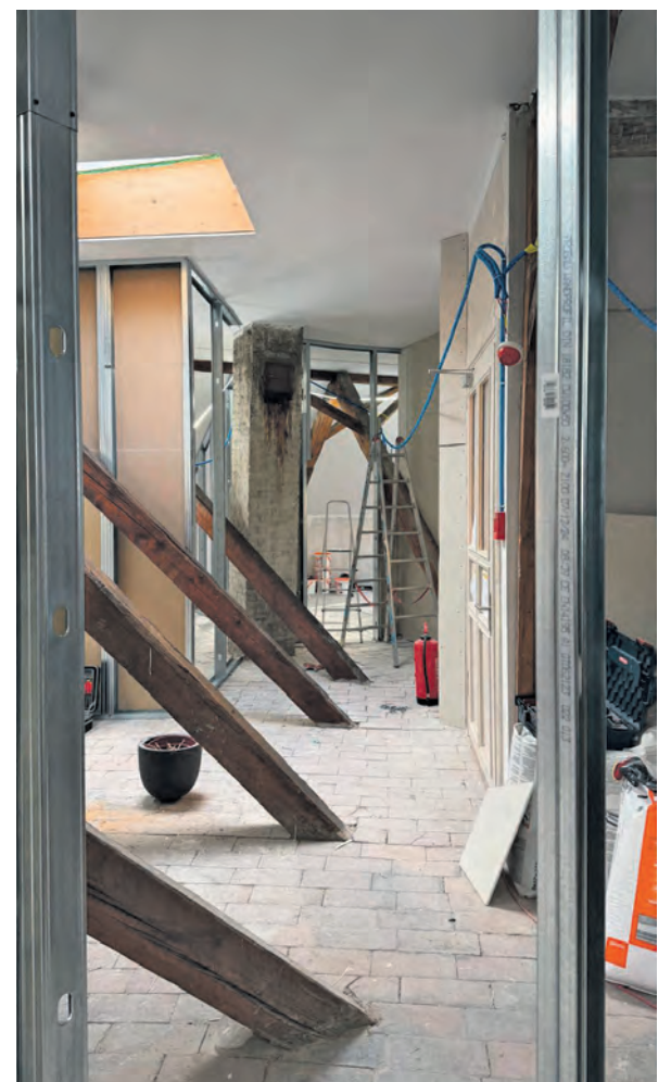
Zahnklinik in Thun während der Ausbaurbeiten.
