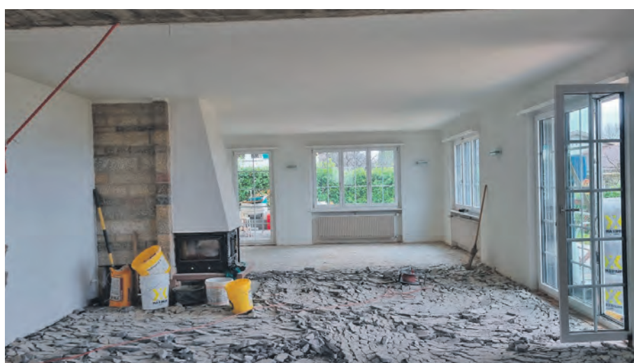
Am Anfang jeder Renovation steht der Rückbau – hier das Einfamilienhaus am Rosenweg.
