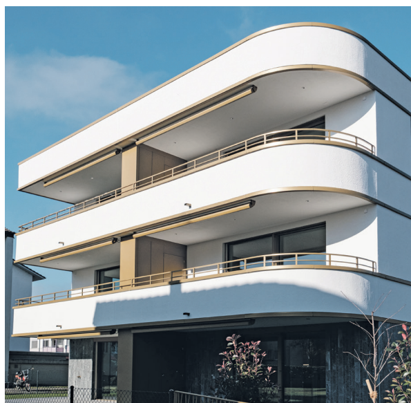
Aussenansicht des Neubaus MFH Aronda Thun.
