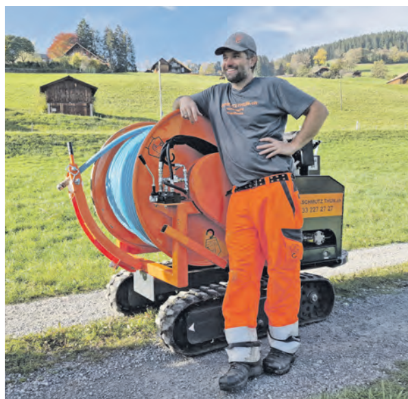
Im Einsatz mit Raupenschlauchverlängerung.
