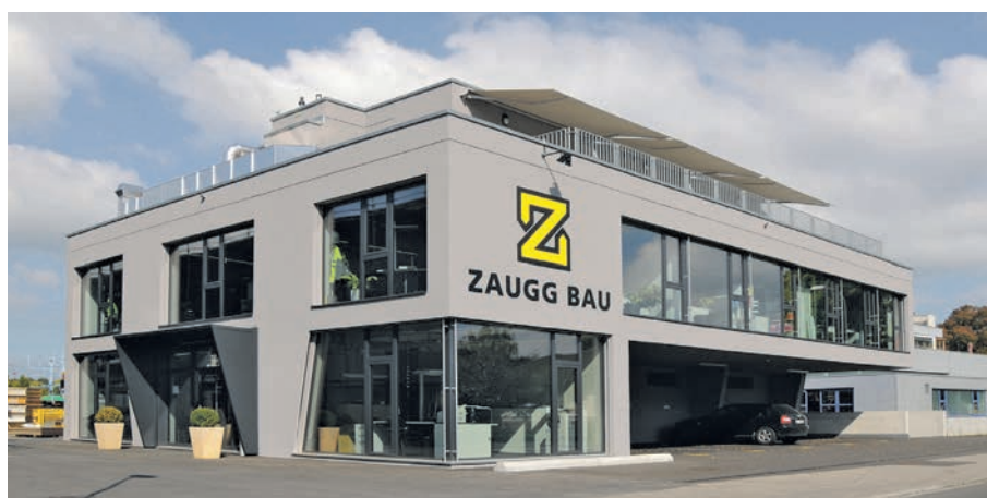
Das Bürogebäude wurde 2012 neu gebaut.
