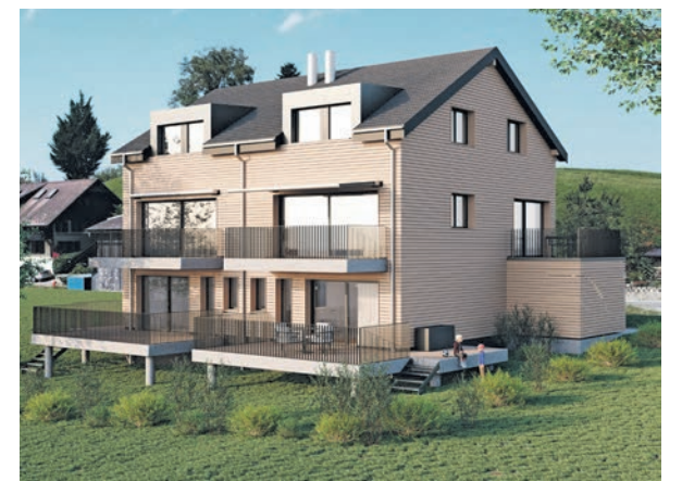
Eigenprojekt Doppel-einfamilienhaus Zwieselberg.
