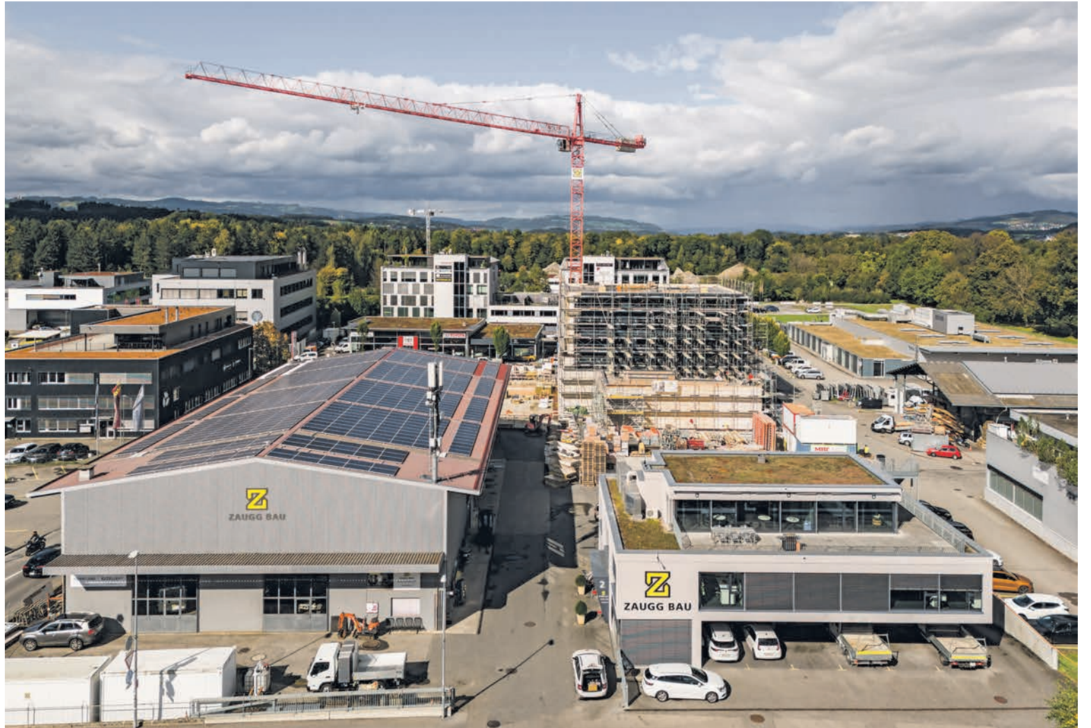
Luftansicht Geschäftssitz Zaugg Bau AG Thun – mit dem Gewerbepark Thun-Süd im Bau.
